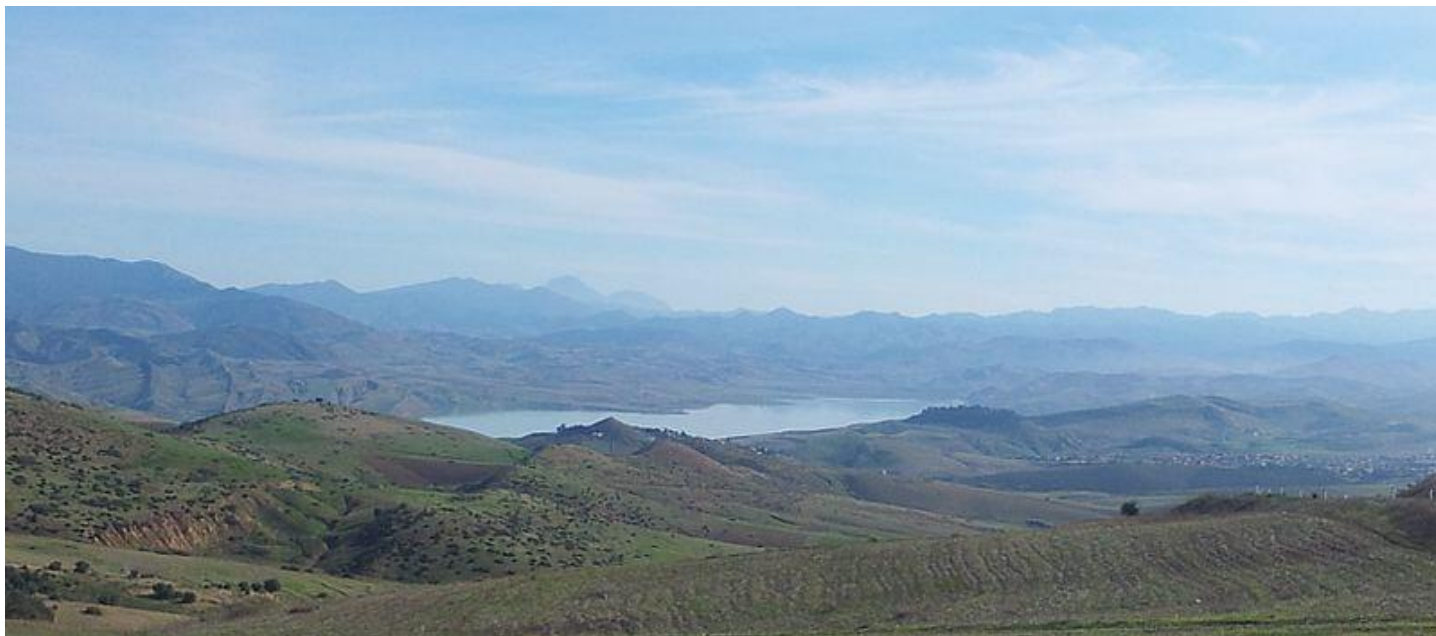
[Barrage de Gargar]
