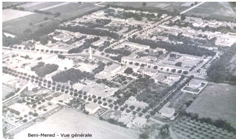
Beni-Mered - Vue générale
