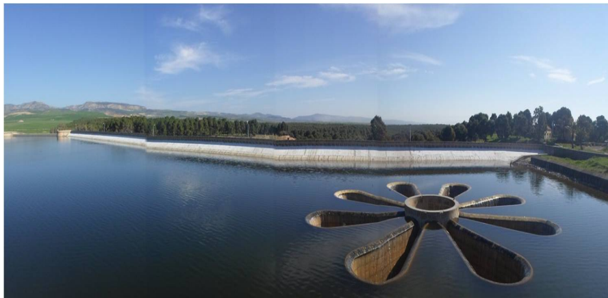
La rosace d'évacuation du lac artificiel SARNO près des TREMBLES.
