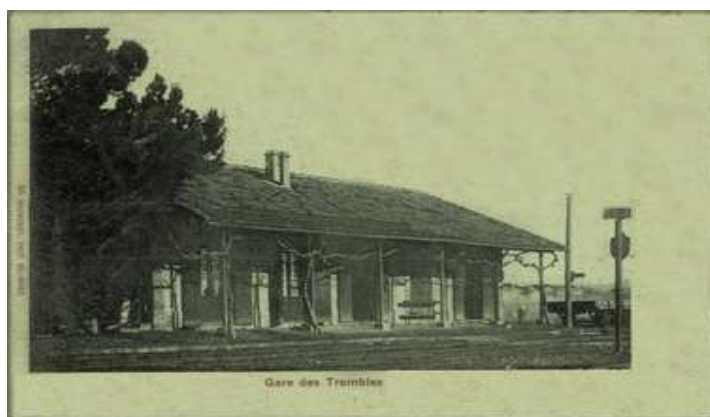
Gare est ouverte sur la nouvelle voie ferrée Oran-Sidi-Bel-Abbès.
