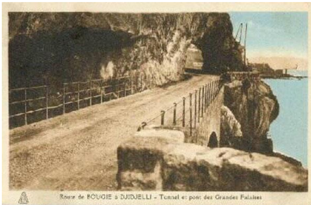
Route des Grandes Falaises. Le premier tunnel et le premier pont ; en arrière-plan le transbordeur.
