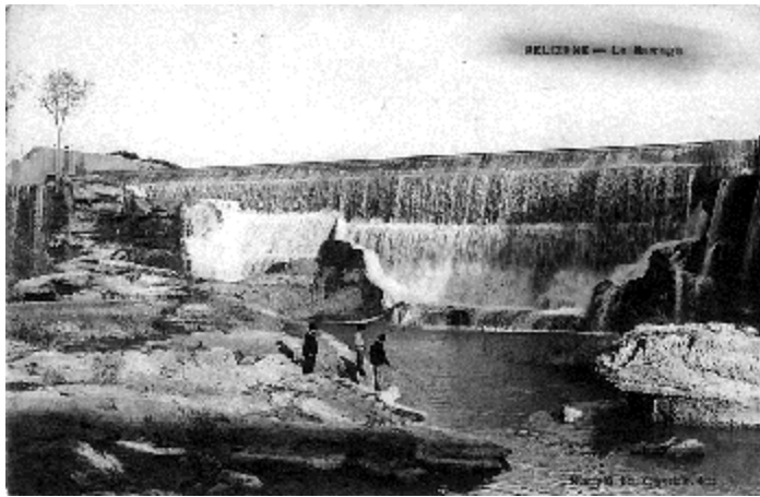
Barrage de RELIZANE
