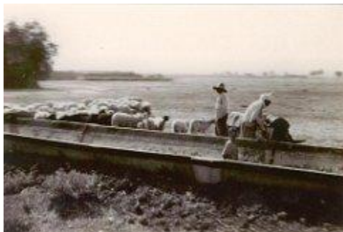
FERRY : Le canal d'irrigation
