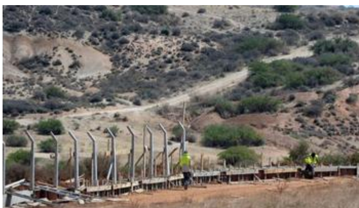
La clôture construite en face du poste frontalier algérien, près d'Oujda, au Maroc. © AFP
