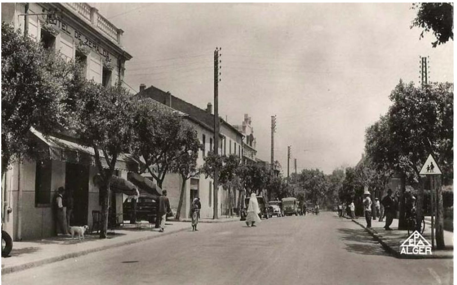
[ZERALDA – Rue Principale]
